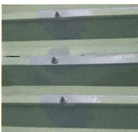
施工前の屋根(遮熱塗装前)
